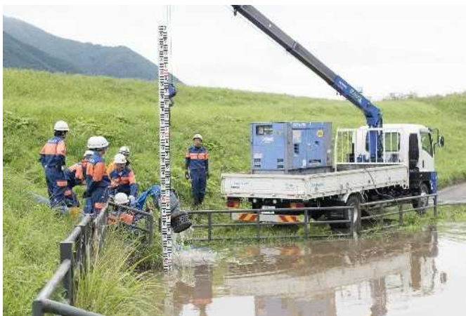
水防団員による水防活動(排水作業)
