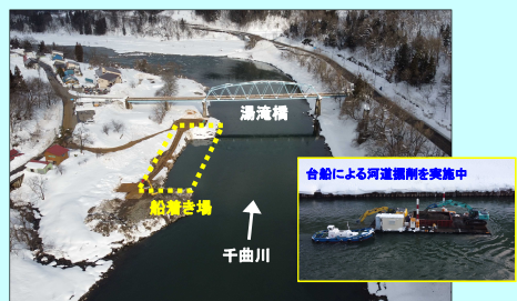
戸狩狭窄部の河道掘削(令和4年2月末時点)
