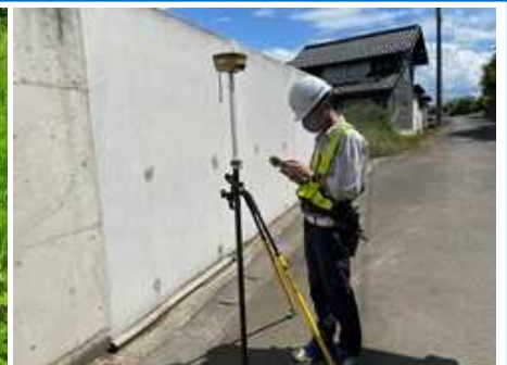
測量作業状況
