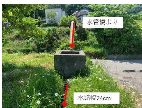
国道117号横断水管橋
