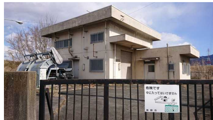
塩崎排水機場 (外観)
