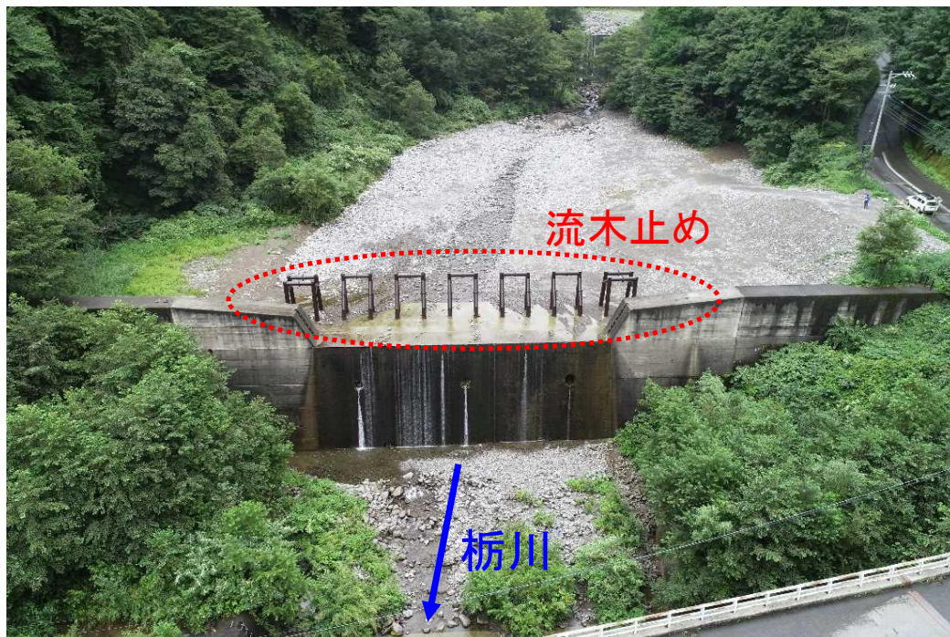
栄村上野原地先（中津川右支川の栃川）の 栃川下流第2号砂防堰堤に流木止めを設置
