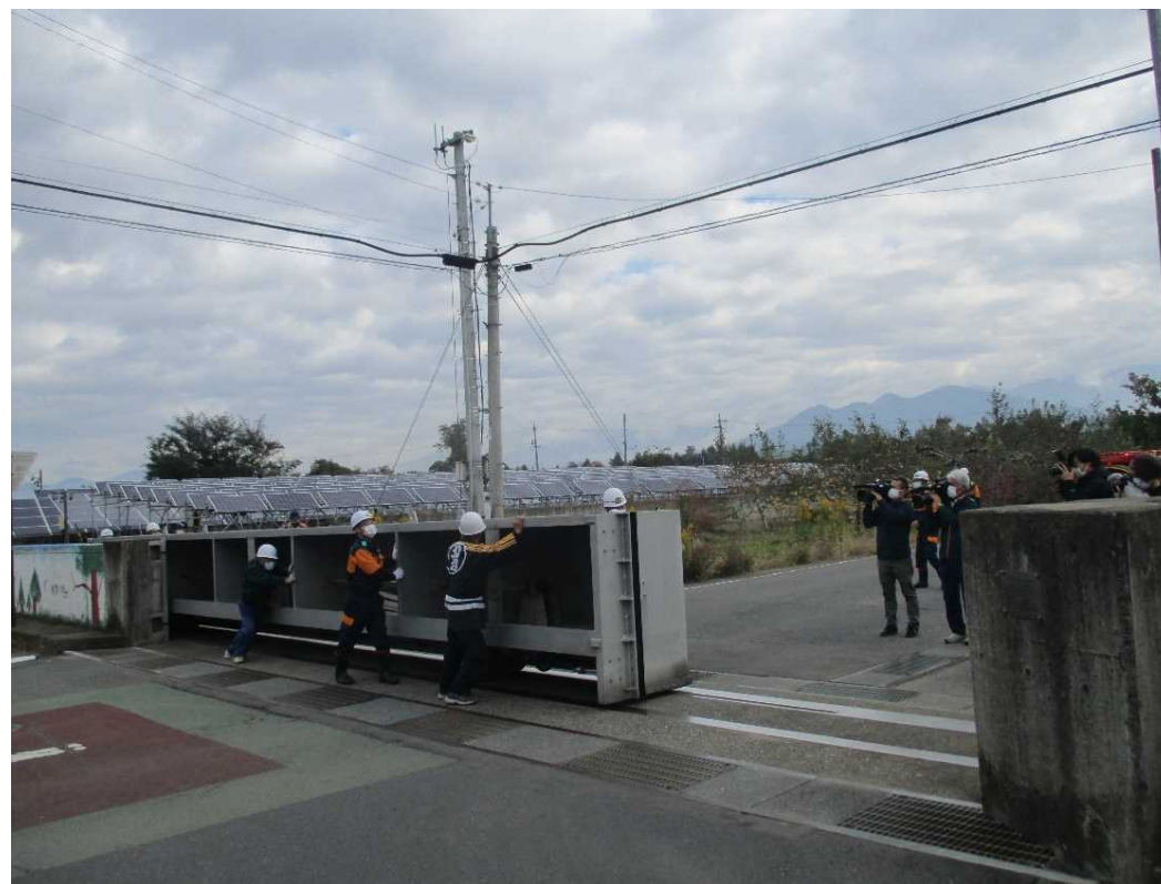
令和4年10月30日(日) 北相之島町コミュニティタイムラインによる運用訓練(横引きゲート(輪中堤の一部)閉鎖訓練:須坂市北相之島町)
