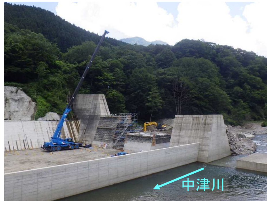
栄村上野原地先において整備中の 中津川上流第1号砂防堰堤
