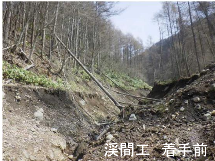
長野県上田市角間山国有林 溪間工
