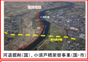
河道掘削(国)、小須戸橋架替事業(国・市)
