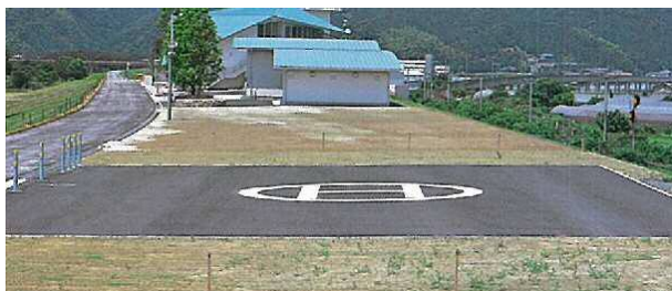
ヘリポートの事例（肱川河川防災ステーション、愛媛県）
