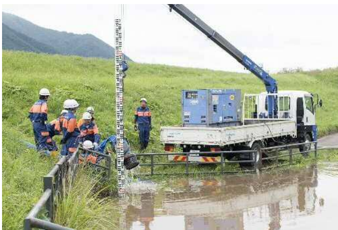
水防団員による水防活動（排水作業）
