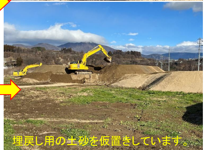
床掘りした土砂を積みこみ。
