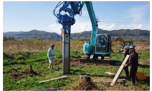
地層抜き取り調査 作業状況
