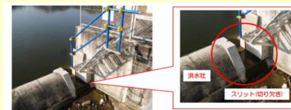
洪水調節機能を強化するためのため池の洪水吐スリットの設置状況
