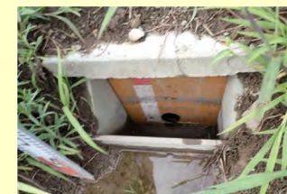
排水調節板の設置
