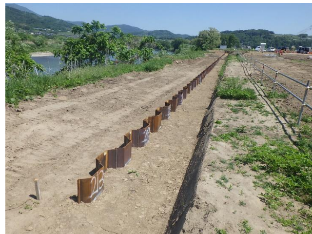
護岸矢板213枚の打ち込み完了
