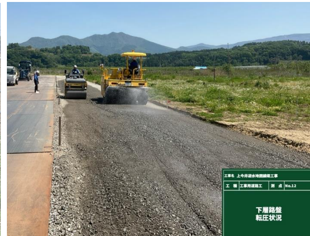
市道大俣線仮廻し道路 路盤工施工状況
