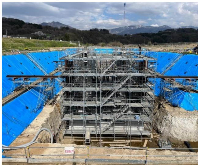
樋門本体の壁と天井部分を施工するための足場を施工中です。
