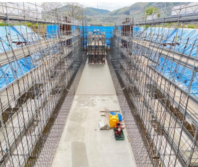
4/22 樋門本体の底部分のコンクリート打設完了しました。
