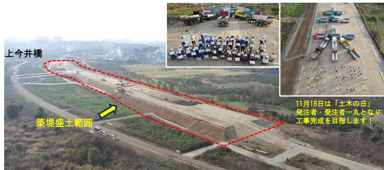
3工区ともに築堤盛土工事は引続き順調に進んでおります。11月中旬時点で全体土量の約70%程度の土砂の運搬・盛土工事が完了しています。今後は冬季路面凍結・スリップ対策等を強化し、日々の点検確認を行い安全運転の励行に努め作業を進めて参ります。引続き、皆様のご理解とご協力をお願いします。
