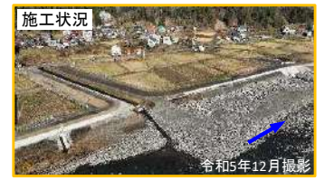
施工状況 新潟県津南町 巻下・小島・押付地区（信濃川 左岸）
