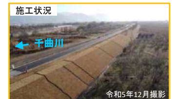
施工状況 長野市 赤沼地区（千曲川）
