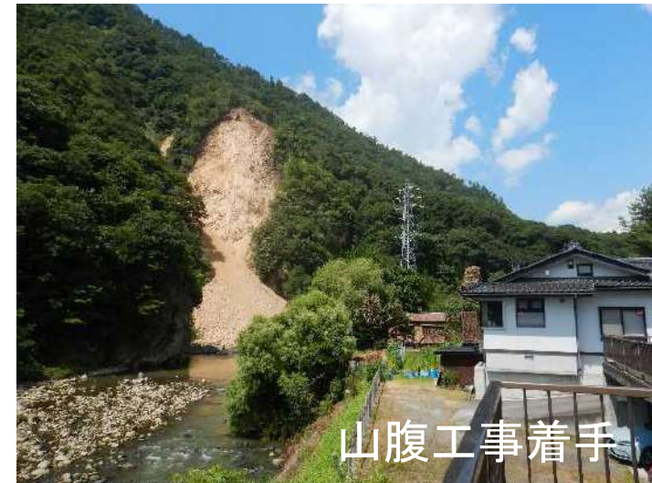
長野市 朝日山国有林 山腹工
