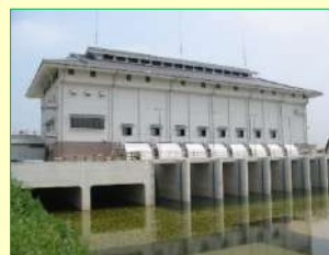
排水機場の管理
