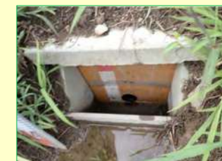
排水調整板の設置
