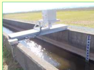
水位計の設置
