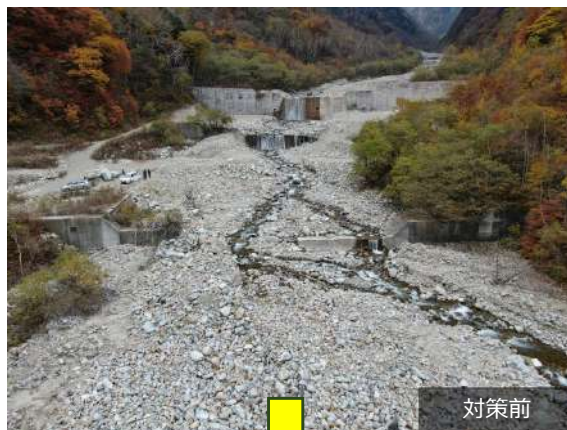
籠川谷国有林（長野県大町市平） 〔扇沢第7・8号堰堤補修工〕
