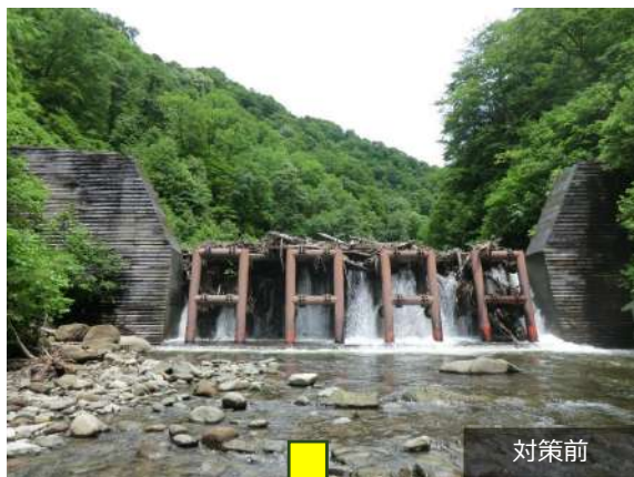
戸隠山国有林（長野県長野市鬼無里） 〔清水沢第2号鋼製スリット谷止工〕
