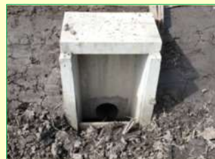
排水口の整備
