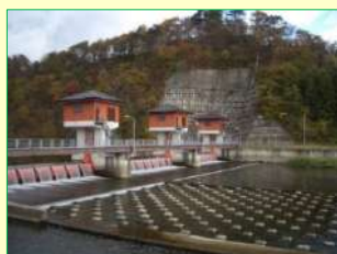
頭首工の管理
