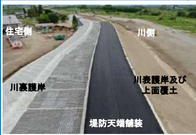
堤防強化(粘り強い河川堤防)
