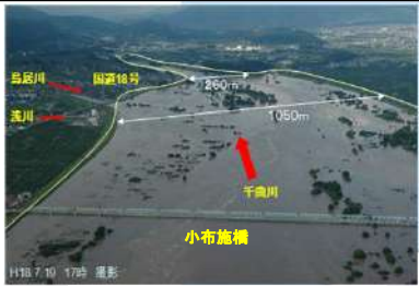
立ヶ花狭窄部掘削
