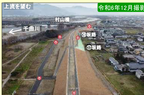
現地施工状況②
