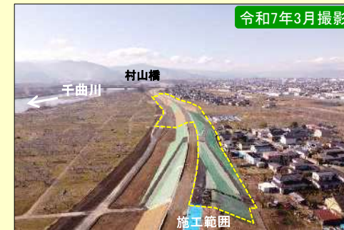
現地施工状況②
