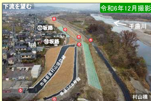
現地施工状況①
