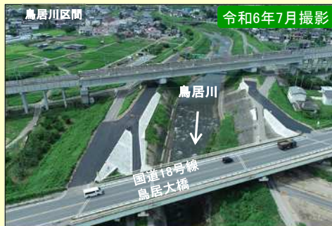
現地施工状況②
