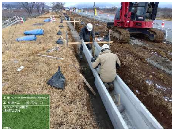
対策②縦断排水路工
