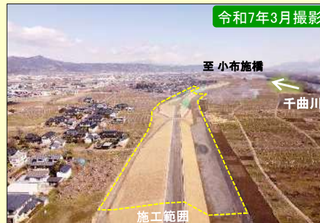
現地施工状況①
