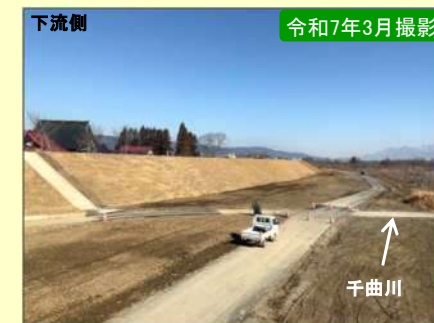
現地施工状況②
