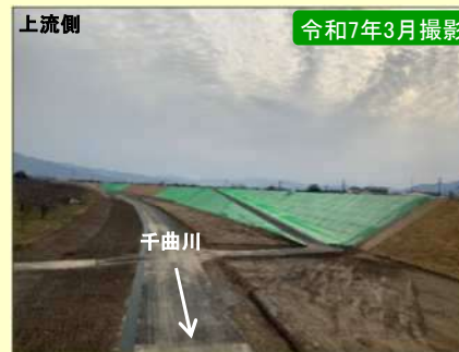
現地施工状況①
