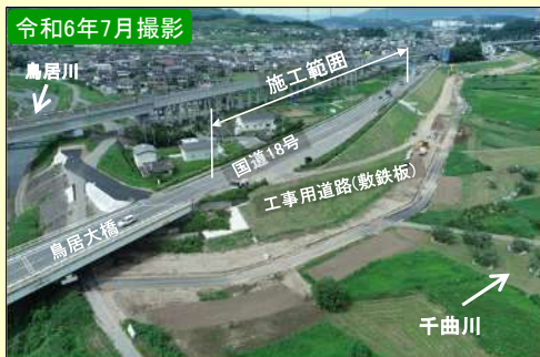
現地施工状況①
