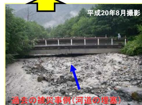
堆積工で約1,500m<sup>3</sup>の土石流を捕捉
