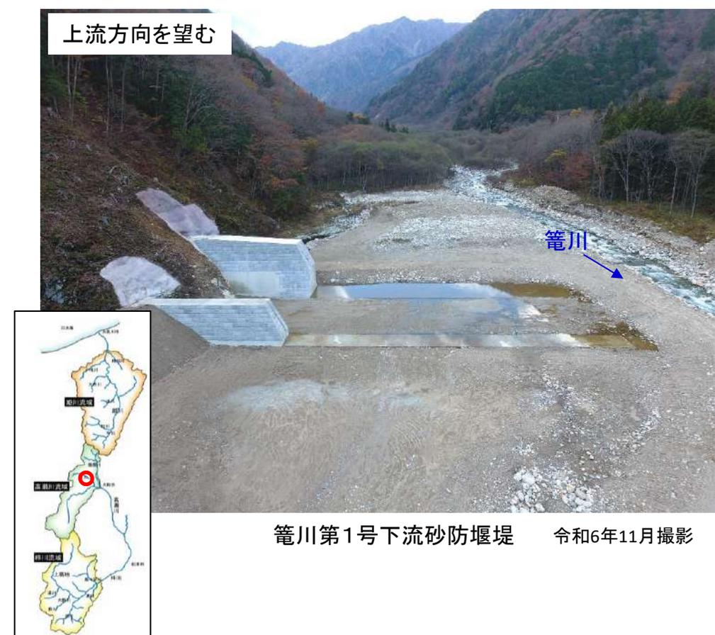
梓川流域奈川左岸において、令和元年5月大雨により斜面崩壊が発生。下流域への土砂流出のおそれがあるため崩壊斜面の対策を実施(令和6年度に対策完了)
