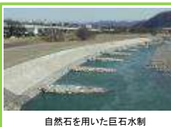
自然石を用いた巨石水制
