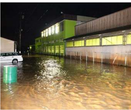
平成22年8月 被害状況
