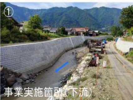
矢出沢川の状況 (①下流部 ②中流部)
