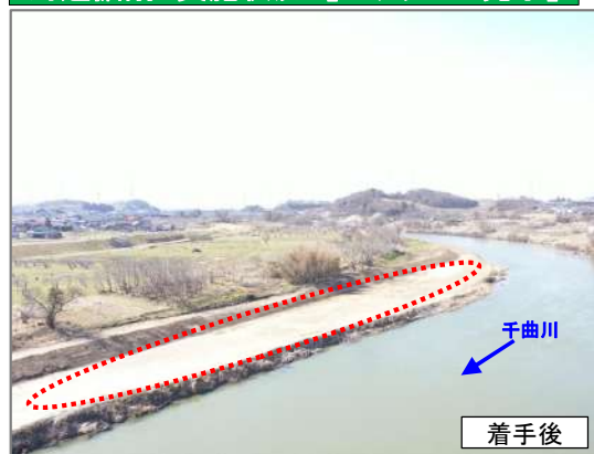
河道掘削 実施状況【ステップ3完了】
