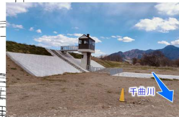
樋門の整備事例 (植生遊水地排水樋門の完成状況)
