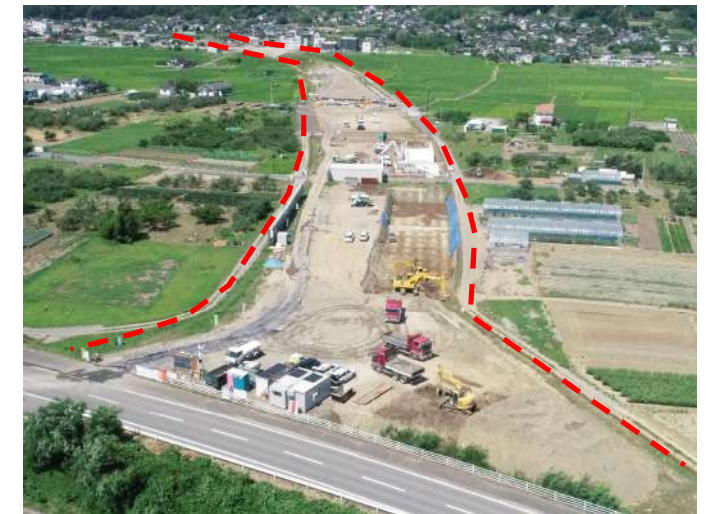
【長野市塩崎地区の工事状況】
