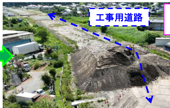
ステップ2 仮置き土砂搬出 (道路予定地 → 遊水地予定地)
