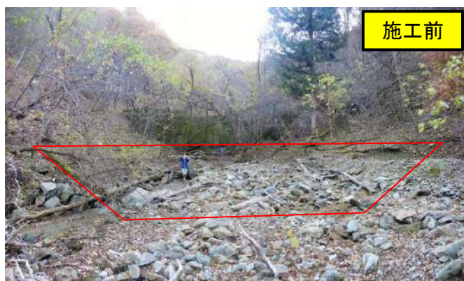
荒廃地の復旧
