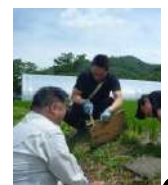
職員直営で柵板加工
