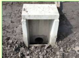
排水口の整備
