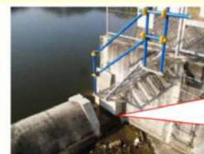
ため池の洪水調節機能を強化するための「洪水吐きスリット」設置状況
