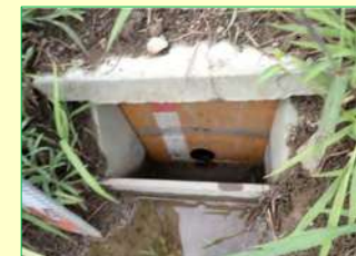
排水調整板の設置
