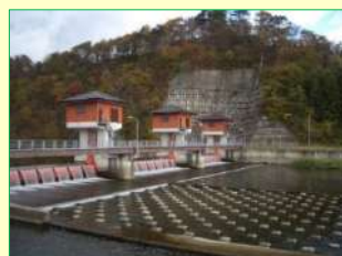
頭首工の管理
