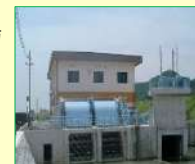
排水機場 の整備
