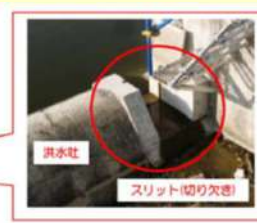
ため池の洪水調節機能を強化するための「洪水吐きスリット」設置状況
