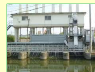
排水樋門の管理
