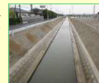
排水路 の整備
