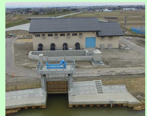
排水機場全景
