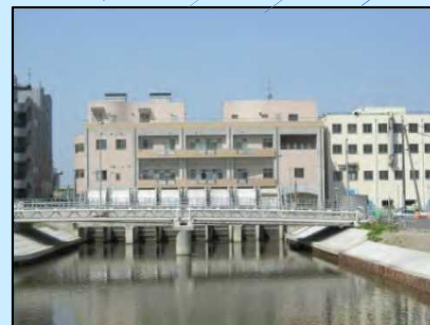
排水機場全景
