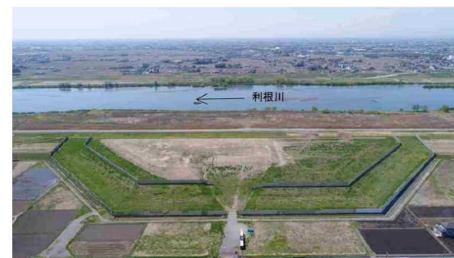
栄地区広域避難地(埼玉県加須市)
