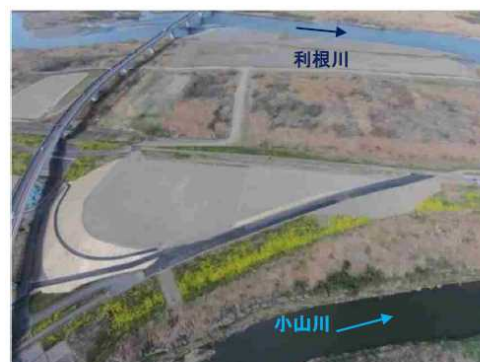
下高島地区(埼玉県深谷市)
