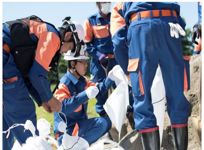
土のう製作・水防工法訓練
