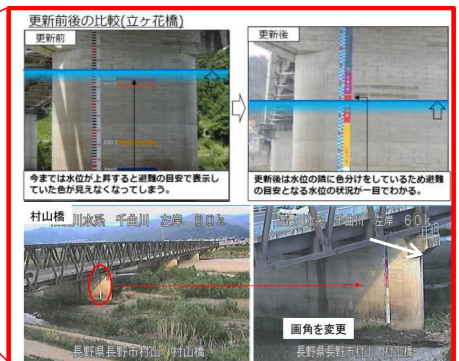
【わかりやすい量水標】 令和2年度よりNHK長野放送局と意見交換会を行い、量水標の 危険度のわかりやすさを更新。必要時には面角を変更してアップにする。
