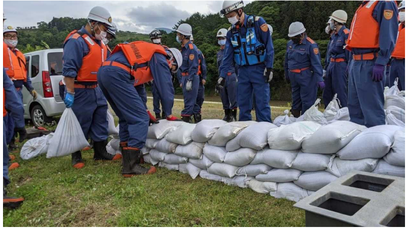
消防団員による土のう積み工法
