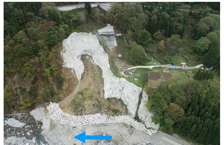
栄村屋敷地先において溪岸侵食に伴う 斜面崩壊対策を実施中
