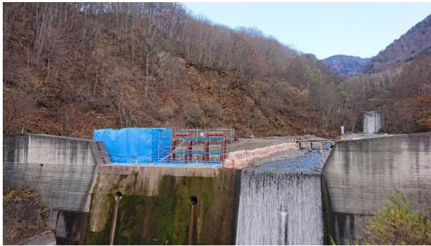
栄村上野原地先において流木止めを整備中の 栃川下流第2号砂防堰堤
