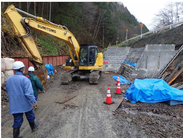
境川溪流保全工施工現場
