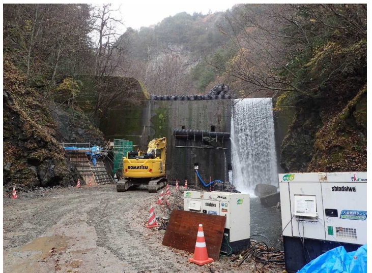
番所砂防堰堤施工現場
