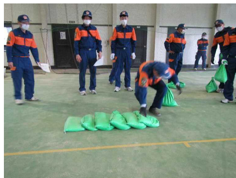
水防訓練での消防団員による土のう作り、土のう積み
