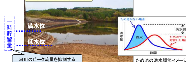
長野市浅川大池（低水位管理の様子）
