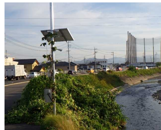
【 簡易型河川監視カメラ 】
