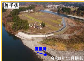
48: 小千谷市 塩殿地区 (信濃川 左岸)
