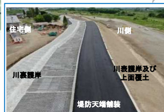
堤防強化(粘り強い河川堤防)
