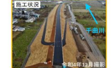
施工状況 千曲川 令和4年12月撮影 長野市 穂保地区 (千曲川)
