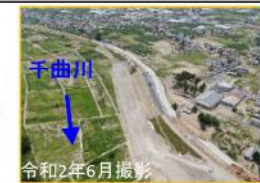
千曲川 令和2年6月撮影 長野市 穂保地区 復旧状況
