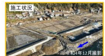
施工状況 新潟県津南町 巻下・小島・押付地区 (信濃川 左岸) 令和4年12月撮影
