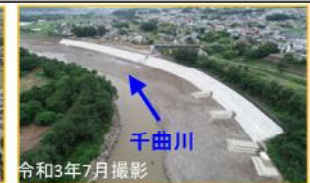
千曲川 令和3年7月撮影 東御市 本海野地区 復旧状況
