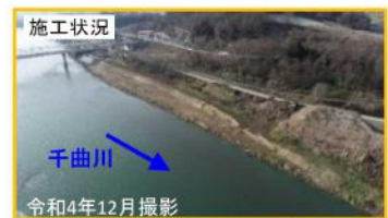
施工状況 千曲川 令和4年12月撮影 中野市 立ヶ花地区 (千曲川)
