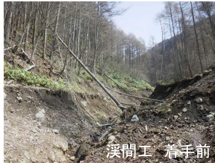
長野県上田市角間山国有林 溪間工
