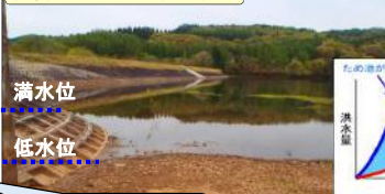
長野市浅川大池（低水位管理の様子）
