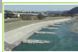
自然石を用いた巨石水制
