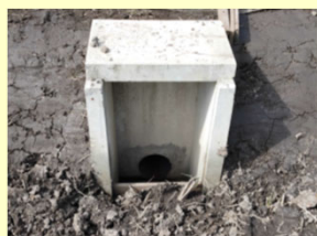
排水桝の整備
