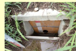
排水調節板の設置
