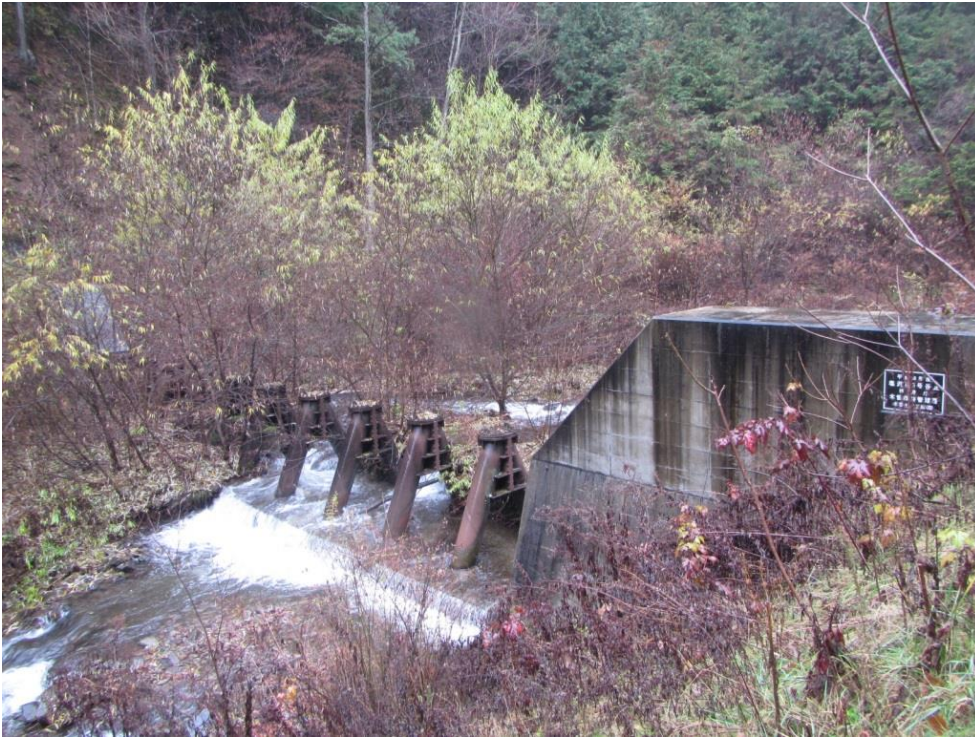
鋼製スリット谷止工（H28時点）
