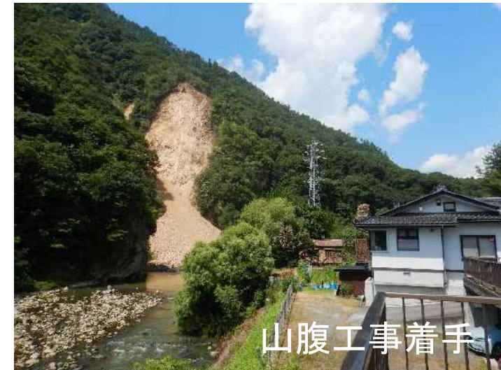
長野市 朝日山国有林 山腹工
