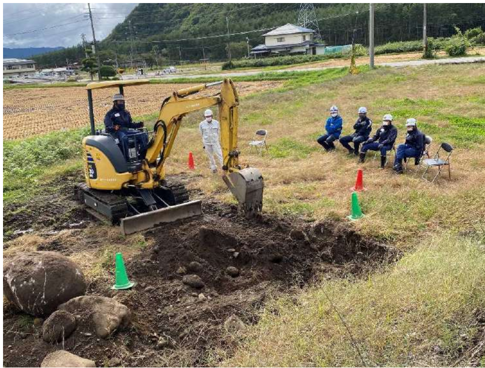
令和5年9月23日(土)～24日(日) 小型車両系建設機械運転特別教育(整地・運搬・積込用 及び掘削用)の様子
