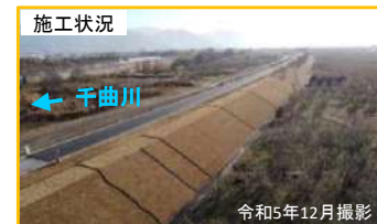
施工状況 長野市 赤沼地区（千曲川）
