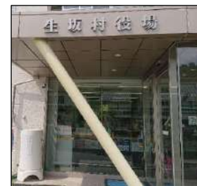
■雨水貯留タンク（生坂村役場）
