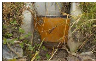
■調整板の設置イメージ
