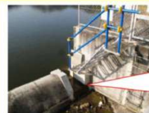
ため池の洪水調節機能を強化するための「洪水吐きスリット」設置状況
