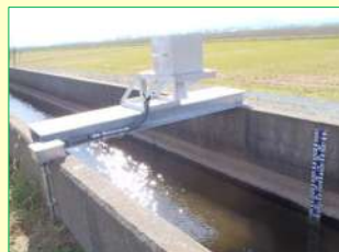
水位計の設置
