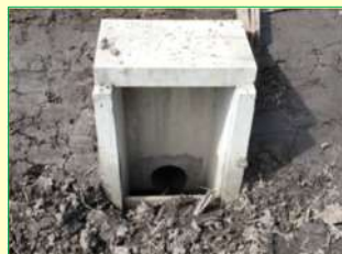
排水口の整備
