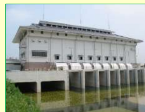
排水機場の管理
