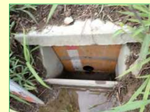
排水調整板の設置
