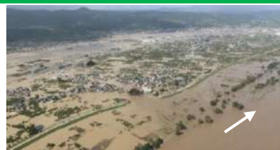
長野市穂保地先の堤防決壊、 湧水被害状況
