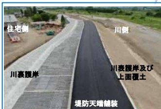
堤防強化(粘り強い河川堤防)
