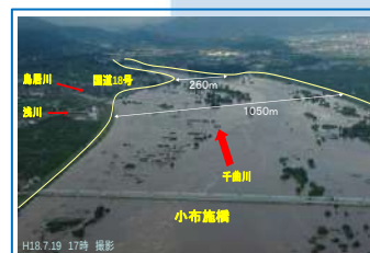
立ヶ花狭窄部掘削
