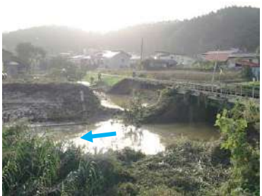
被災直後 工事完成
