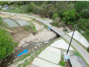
被災直後 工事完成
