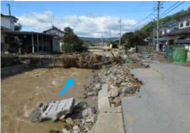
被災直後 工事完成
