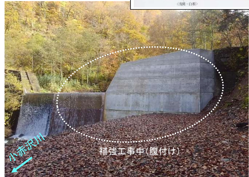
土石流危険溪流である中津川支川小赤沢川において 補強工事中の「小赤沢第22号砂防堰堤」 (栄村小赤沢地先)
