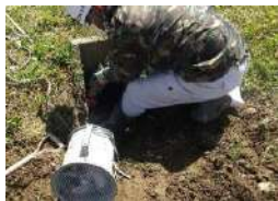
既存柵を改良
