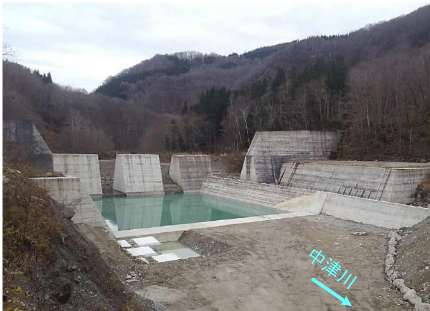
中津川において整備中の 「中津川上流第1号砂防堰堤」 (栄村上野原地先)
