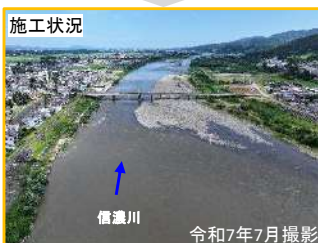
49: 小千谷市 東栄地区 (信濃川 右岸)
