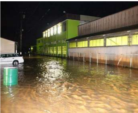
平成22年8月 被害状況
