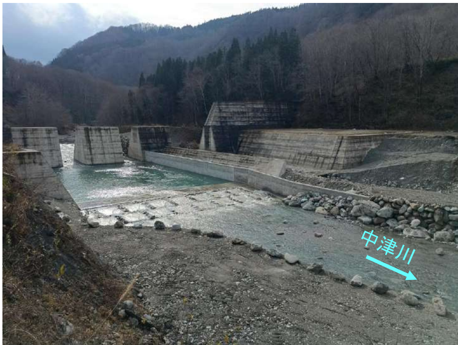
中津川において整備中の「中津川上流第1号砂防堰堤」 (栄村上野原地先)
