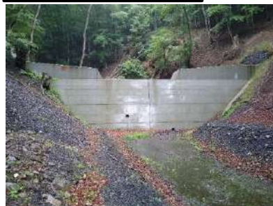
台風、豪雨等により荒廃した溪流には谷止工等の施設を設置
