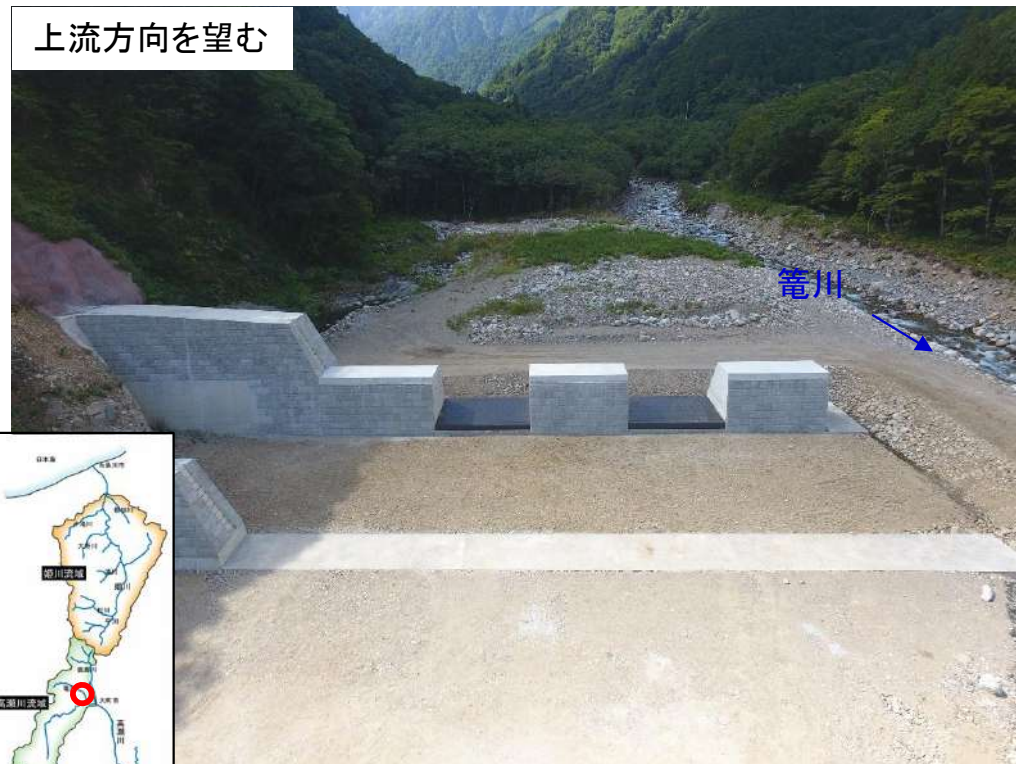
箆川第1号下流砂防堰堤
