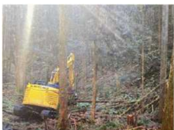
間伐に合わせて伐倒木を横木として伏せる簡易治山施設工の設置により表土の侵食を防ぐ
