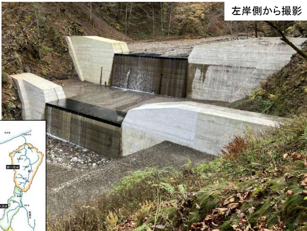
障子川瀬沢砂防堰堤改築
