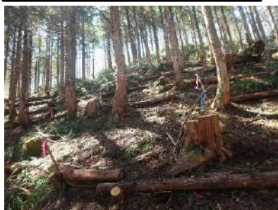
間伐に合わせて伐倒木を横木として伏せる簡易治山施設工の設置により表土の侵食を防ぐ
