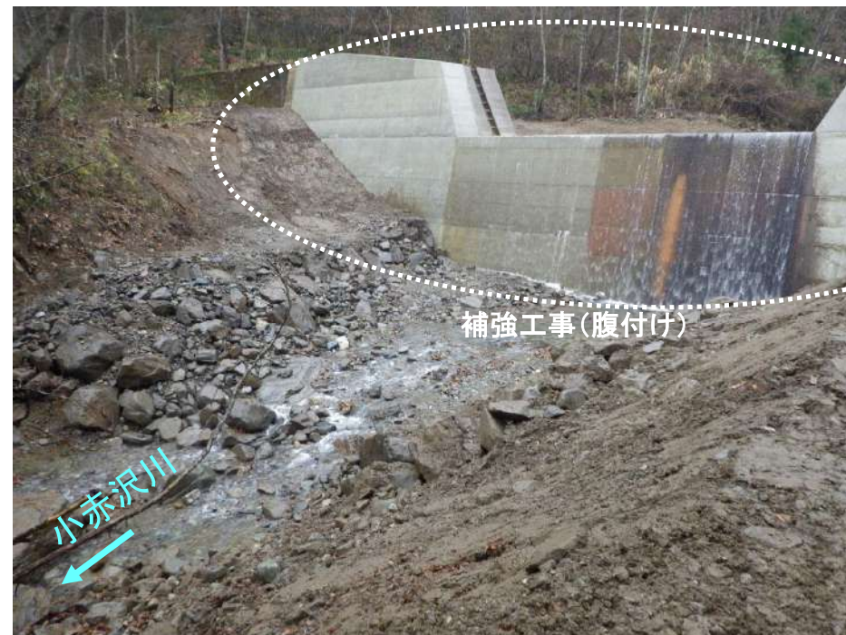
土石流危険溪流である中津川支川小赤沢川において補強工事が完成した「小赤沢第22号砂防堰堤」(栄村小赤沢地先)
