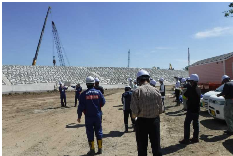
工事概要の説明
