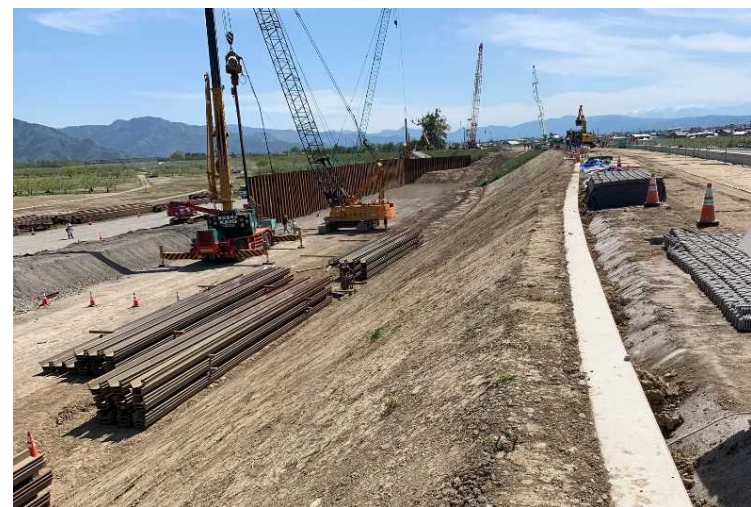
工事の施工状況
