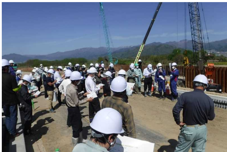
堤防天端にて施工状況の説明
