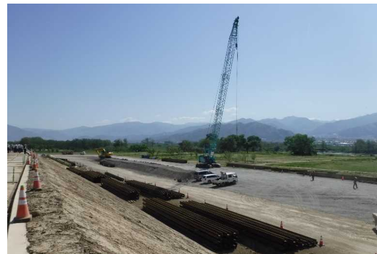
工事の施工状況
