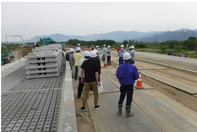
堤防天端にて施工状況の説明
