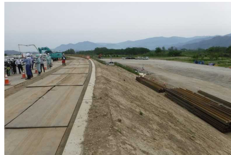
工事の施工状況
