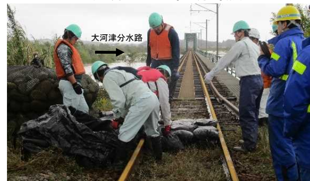
(右岸)土のう積 作業状況(燕市)
