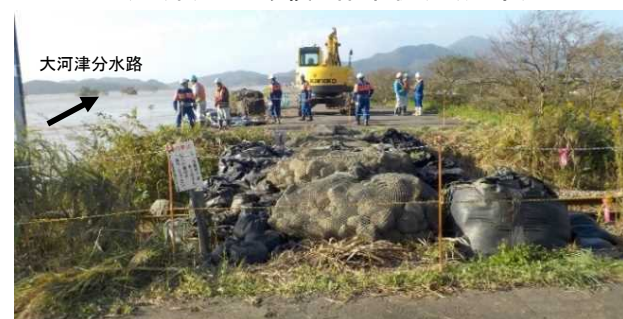
(右岸)土のう積 作業完了(燕市)
