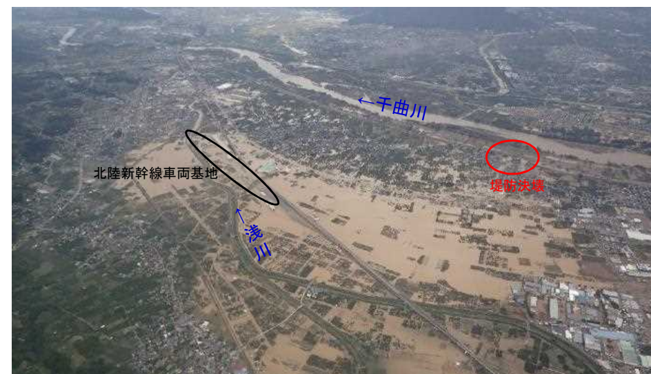
浸水状況(ヘリ調査10月14日11時撮影)
