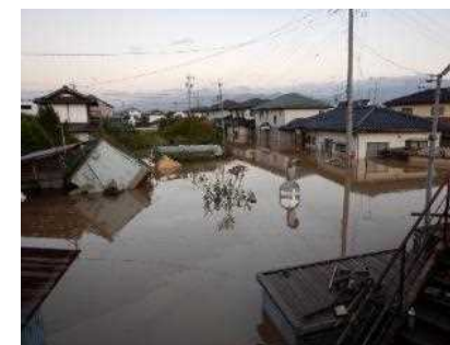
浸水状況(豊野地先10月13日17時撮影)
